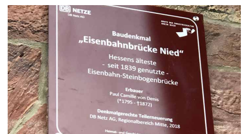
Deutschlands zweitälteste Eisenbahnbrücke über die Nidda in Frankfurt wurde bereits saniert – viele andere Brücken haben das noch vor sich.
